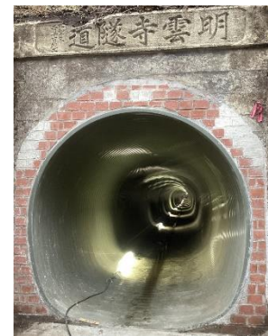
水路トンネルの補修工事「船生用水」(塩谷町内)
