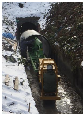
水路トンネルの補修工事「船生用水」(塩谷町内)
