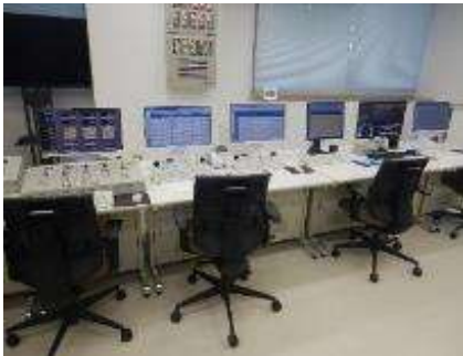
深山ダム：諸量演算装置更新工事
