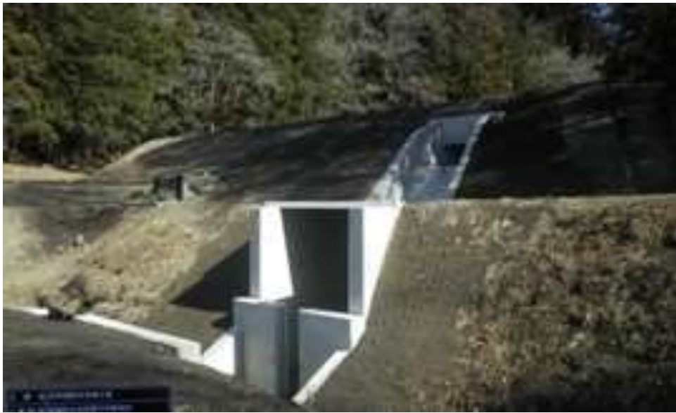
豪雨対策のために洪水吐を設置
