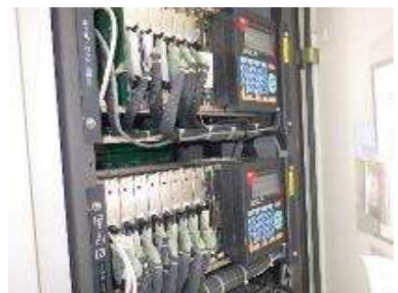
板室ダム：遠方監視制御装置PLC更新工事
