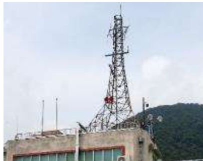
深山ダム：既設通信鉄塔解体工事
