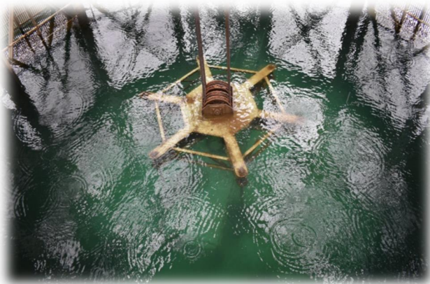
⑥ 取水フロート沈設中
