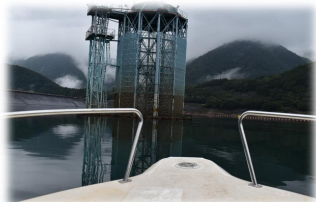
② 取水塔到着
