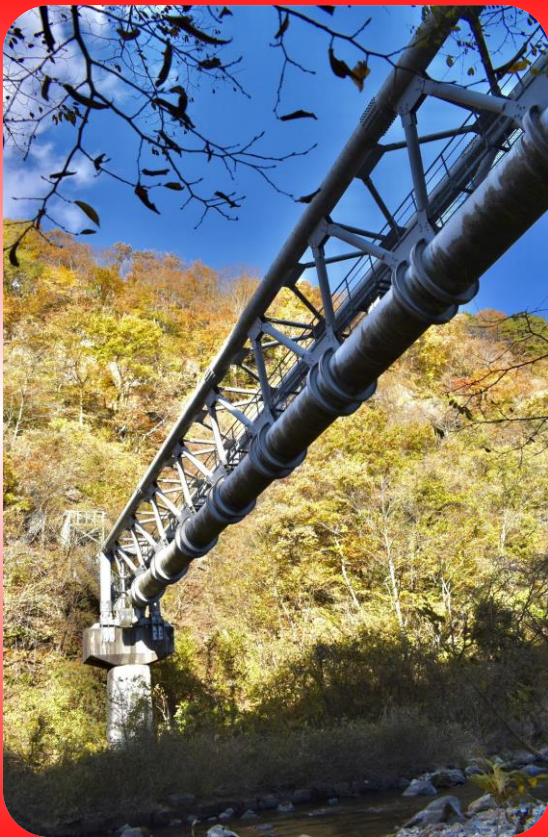
上段幹線水路(那珂川水管橋)
