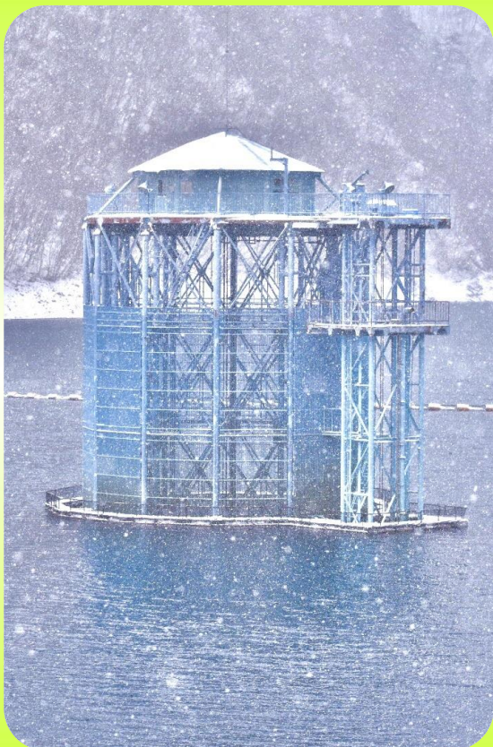
かんがい・発電・水道用水を休むことなく届ける取水塔
