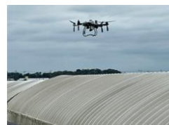
ドローンを使った遮熱塗布材散布
