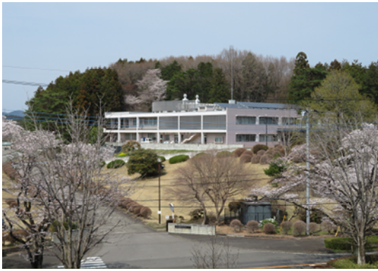
写真1 正門付近から見る本場本館
