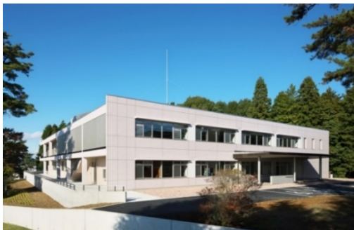
写真2 平成23年度に竣工した本場新本館
