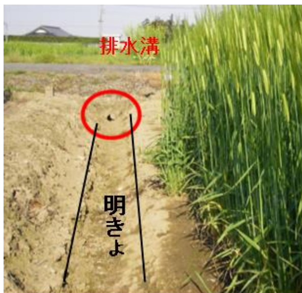
写真2 排水溝に接続されている明きよ
