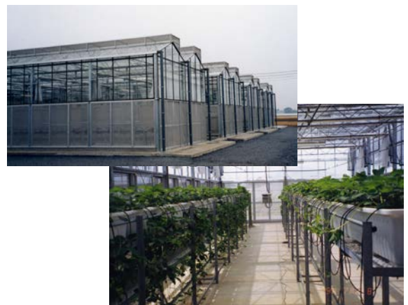
完成した原々苗総合生産施設
