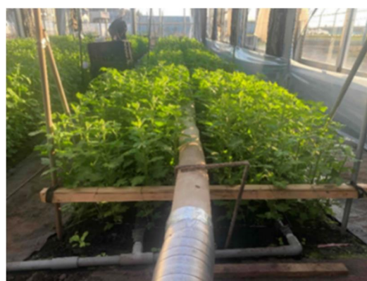
図2 ダクト設置の様子
