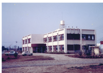
栃木分場本館完成 (昭和 49(1974)年)
