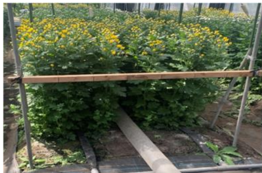
図1 畝内ダクトの様子
