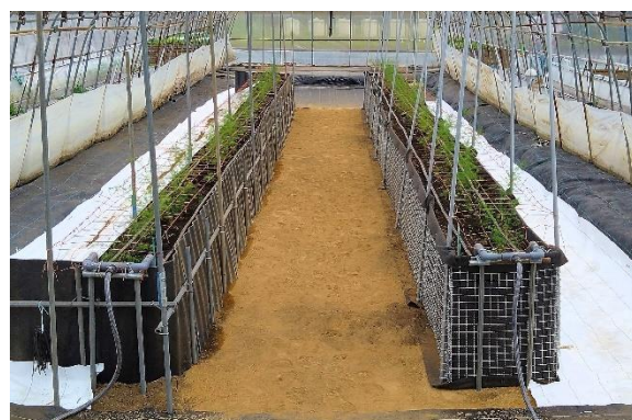
図2 施工完了後の写真
