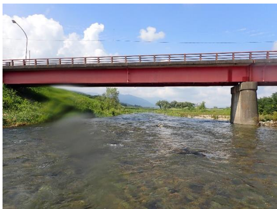
地点14 宇津野橋 下流
