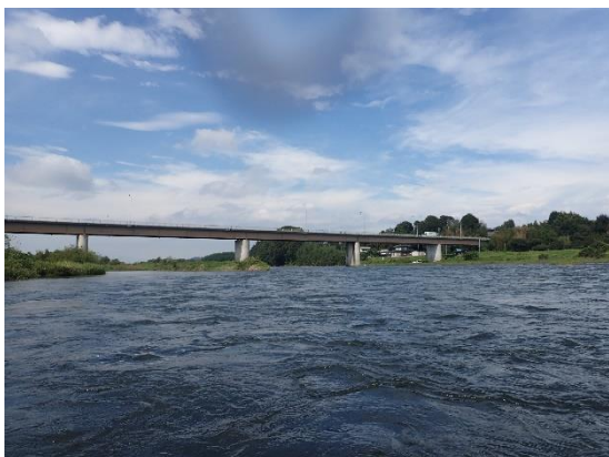
地点7 八溝大橋 下流
