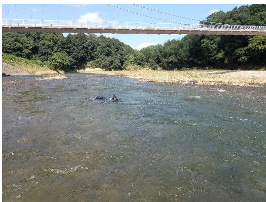
地点23 大金吊り 橋上流
