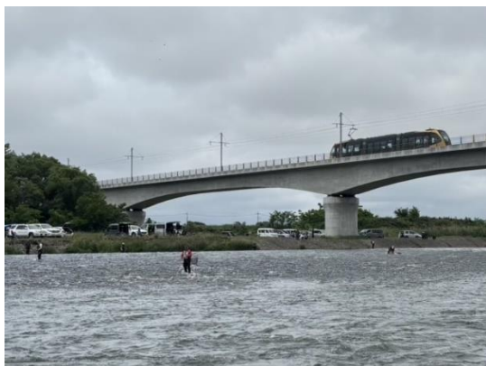
LRT橋周辺の様子
