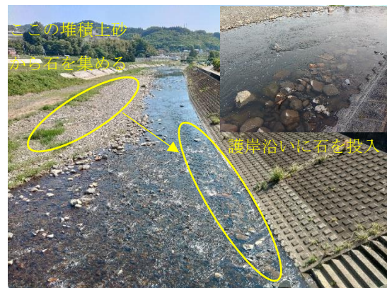
写真3 施工後の様子
