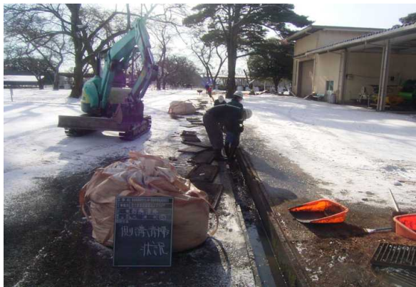
側溝内の堆積物の除去
