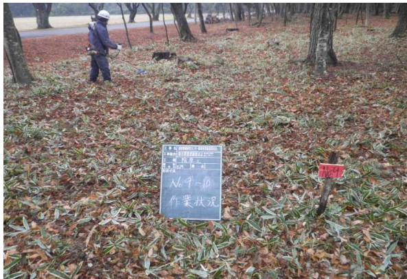
作業の支障となる草などの刈払
