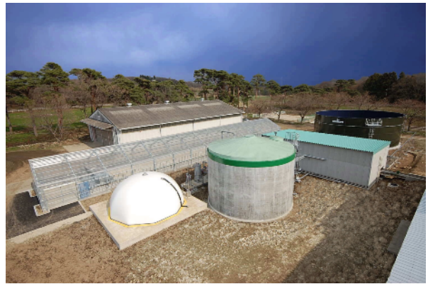
バイオガスプラント全景
