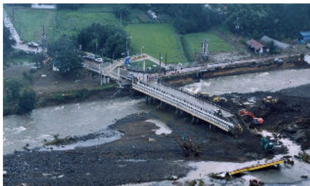
【平成10年8月の豪雨により落橋した余笹橋（国道4号）】
