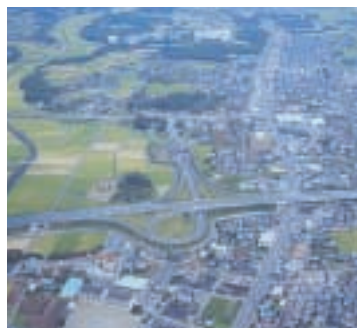
北関東自動車道
