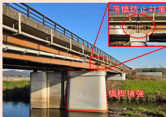
橋梁耐震化(県道西小埴真岡線/田野橋)
