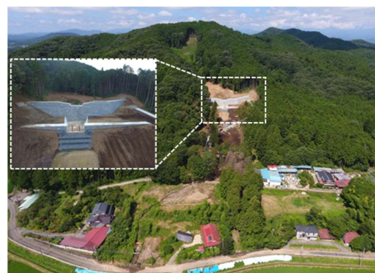
砂防堰堤整備後
