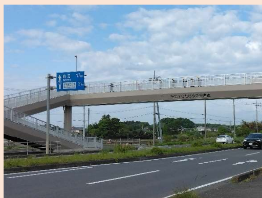
歩道橋整備(県道羽生田上蒲生線/壬生町)
