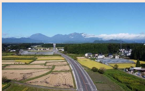
アクセス道路の整備(国道 119 号/日光市)
