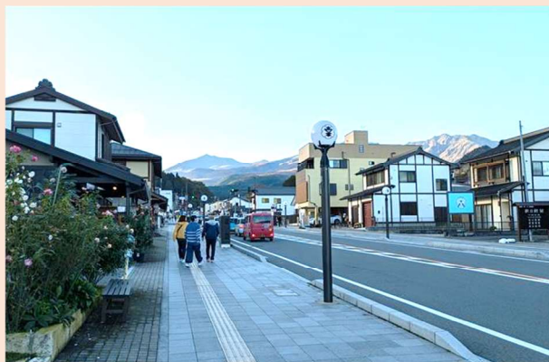
無電柱化(国道 119 号/日光市)
