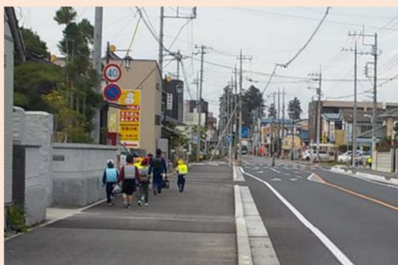
歩道整備(県道真岡那須烏山線/芳賀町)
