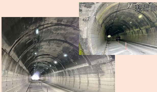
トンネル照明 LED 化(国道 293 号/会沢トンネル)
