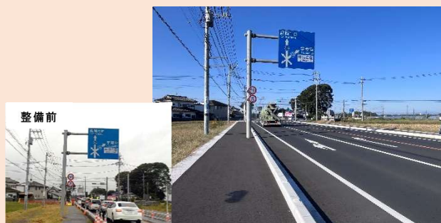
道路の拡幅整備 (国道 121 号/真岡市)
