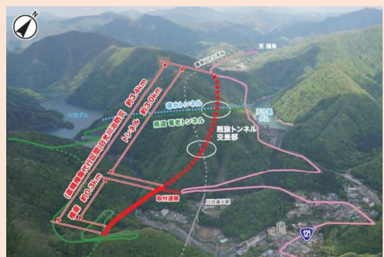
高規格道路の整備 (国道 121 号/日光川治防災)
