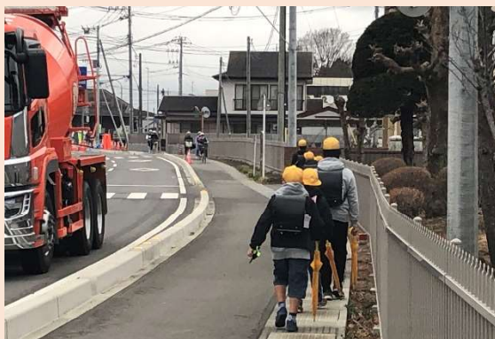
歩道整備(県道杉山石末線/高根沢町)
