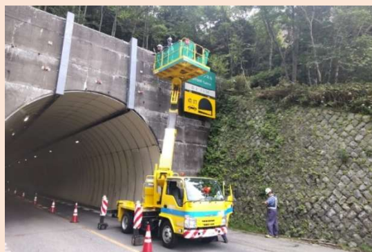
トンネル点検
