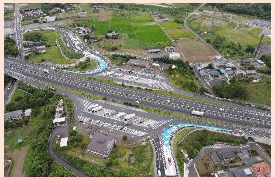
スマート IC の整備 (北関東自動車道/出流原スマート IC)
