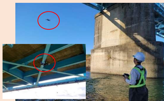
ドローンを活用した橋梁点検
