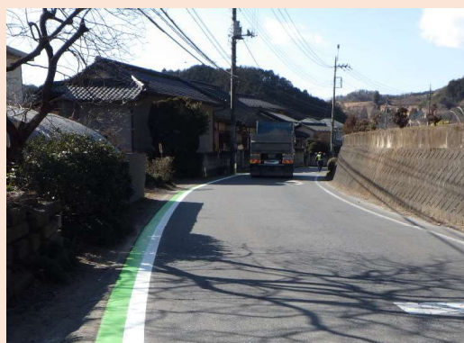
安全対策(カラー舗装) (県道下日向栗野線/鹿沼市)
