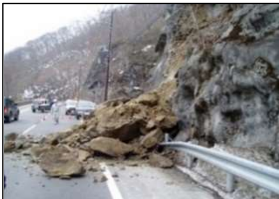
通行不能写真①(国道 121 号/日光市)
