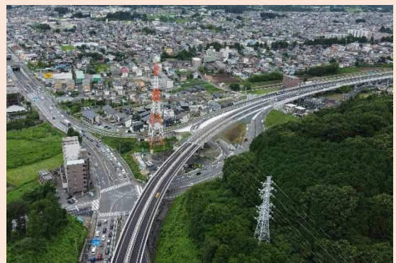
高規格道路の整備 (国道 119 号/宇都宮環状北道路)
