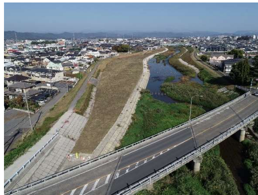
改良復旧後の状況
