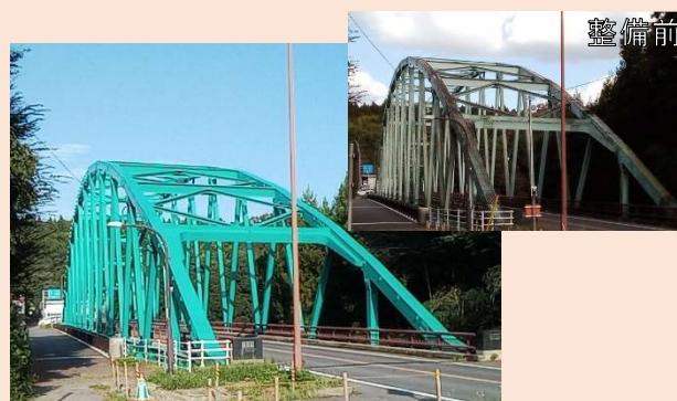
橋梁の長寿命化対策(県道黒磯棚倉線/照明橋)
