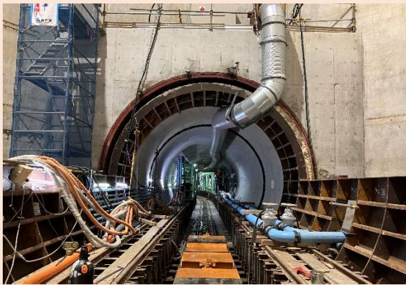
地下捷水路(建設中)(巴波川／栃木市)
