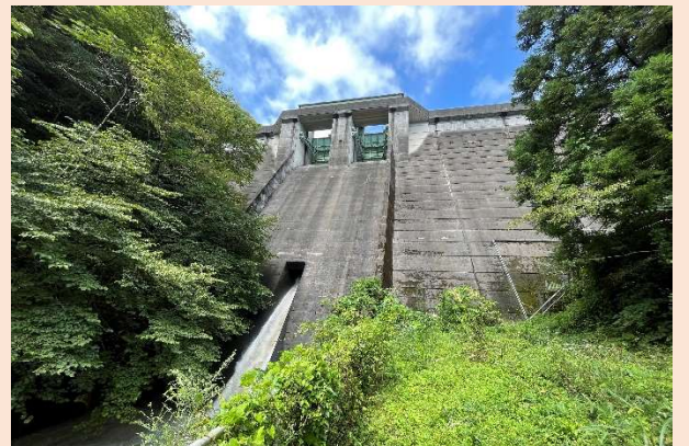
事前放流(西荒川ダム／塩谷町)
