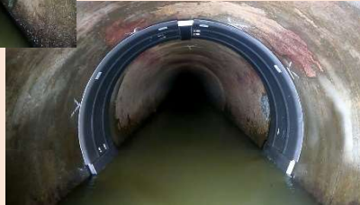
下水道施設耐震化(管渠接合部可とう化)
