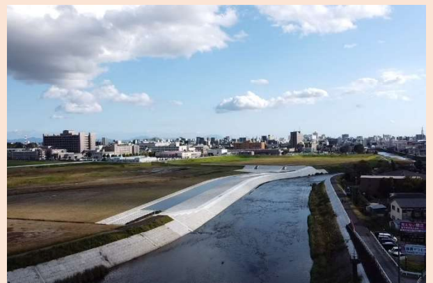
調節池(完成)(田川／宇都宮市)
