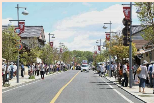
無電柱化(益子南通り/益子町)
