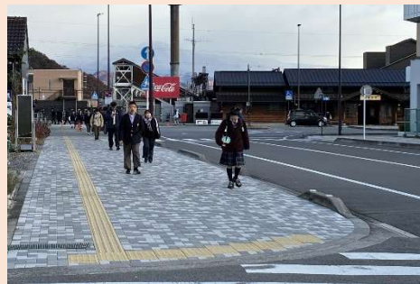
道路のバリアフリー化 (県道下今市停車場線/日光市)
