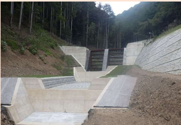
砂防堰堤(完成)(馬場沢／足利市)
