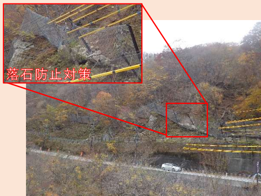
道路の防災対策(国道 121 号/日光市)
