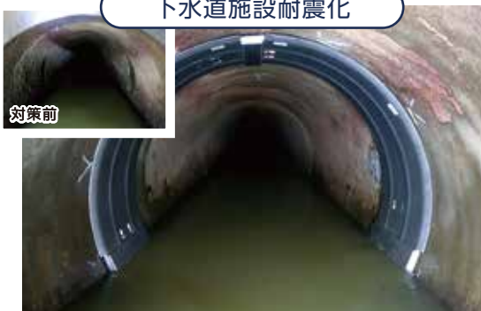
管渠接合部可とう化
