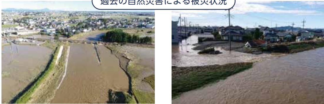
令和元年東日本台風
