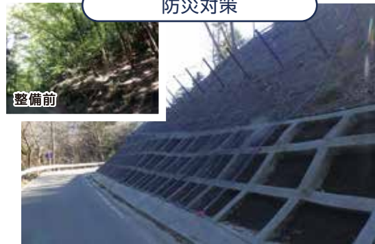
県道塩原矢板線/那須塩原市
