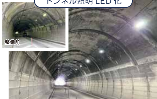
国道293号/会沢トンネル
