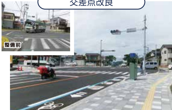
国道294号/那須烏山市
