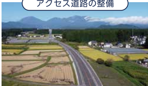
国道119号/日光市
