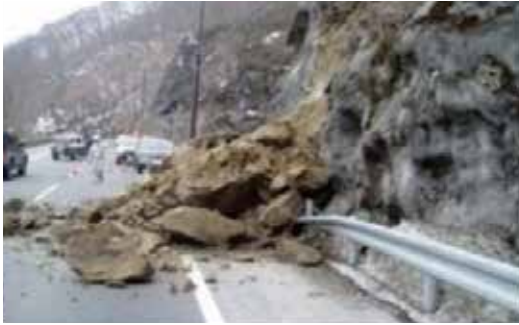
通行不能状況(国道121号/日光市)
