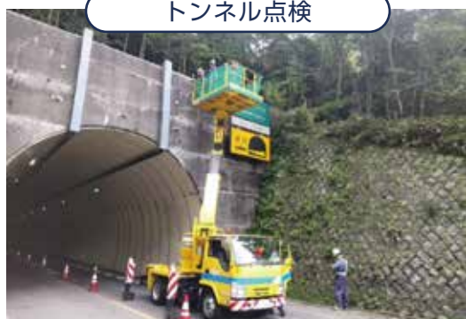
国道120号/金精トンネル
