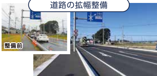
国道121号/真岡市
