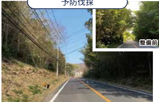
国道294号/茂木町
