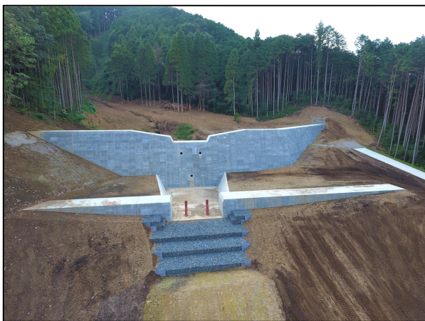
土砂災害防止施設 （下小池二号沢 宇都宮市）
