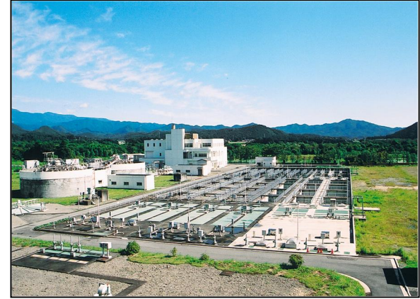
水処理施設（鬼怒川上流浄化センター 日光市）
