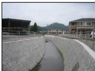
河川整備（小藪川 鹿沼市）
