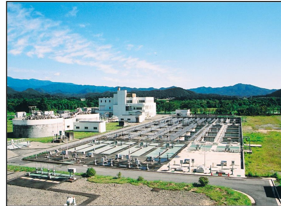
水処理施設（鬼怒川上流浄化センター 日光市）
