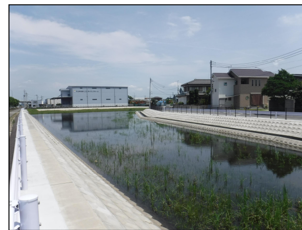
雨水調整池 （武名瀬川第三調整池 上三川町）
