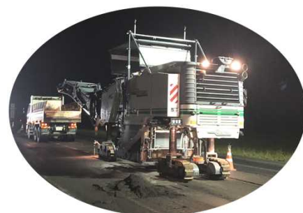
路面切削工（ICT施工）
