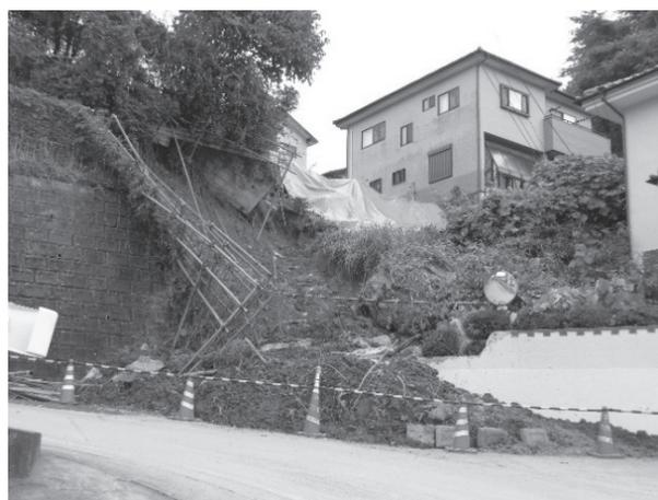
図 11-4-2 豪雨により崩壊した住宅団地
