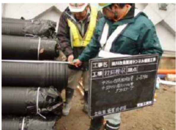
監督職員が現場臨場により「段階確認」や「立会」等を実施
