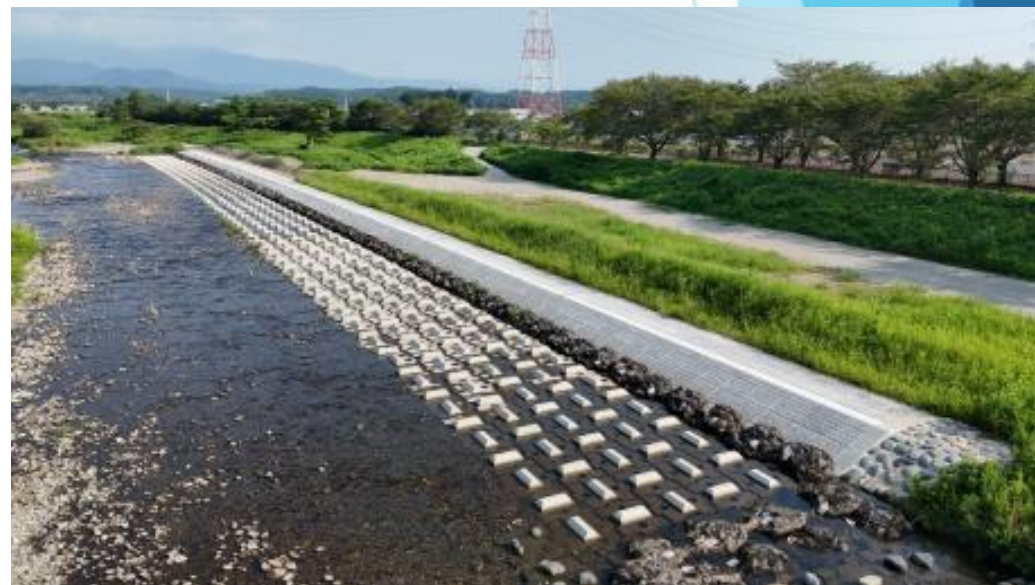
ICT施工によるスピード化を実施した護岸工
