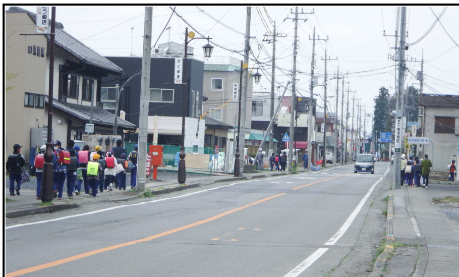
写真② 工区の北側 狭い歩道内に電柱が建っている状況
