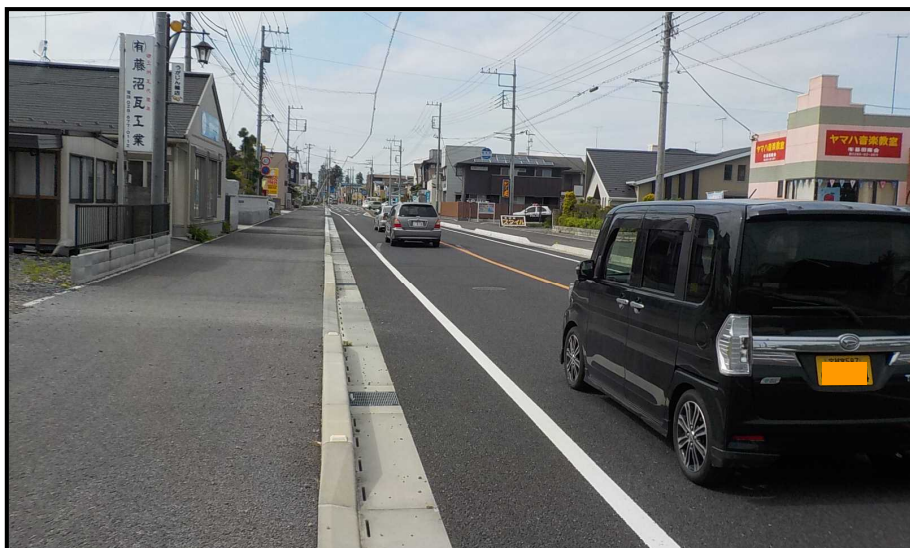
写真③ 工区の南側 整備済区間の状況
