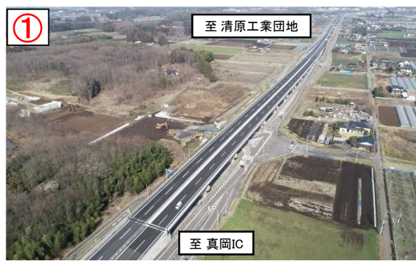
■完成4車線供用区間【清南大地高架橋】
