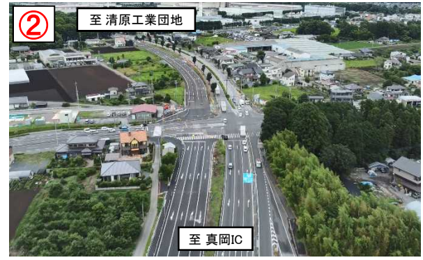
■立体化工事箇所【清原工業団地交差点】
