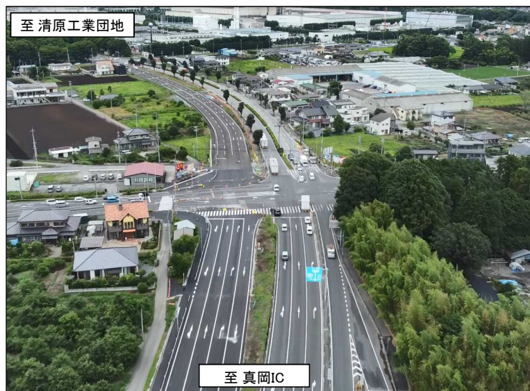
立体化工事箇所【清原工業団地交差点】
