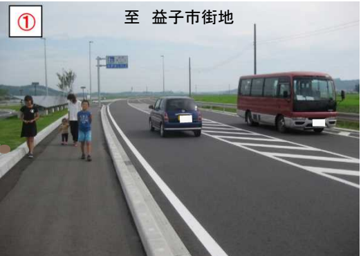
■バイパス供用区間【道の駅ましこ前】
