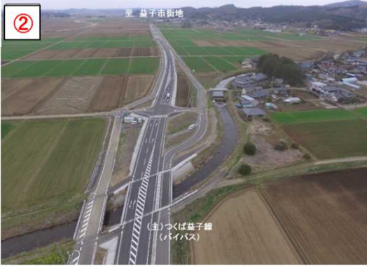
■バイパス供用区間【ぐみ川付近】
