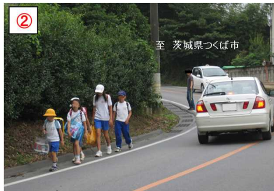
■歩道がなく通学児童が大変危険な状況
