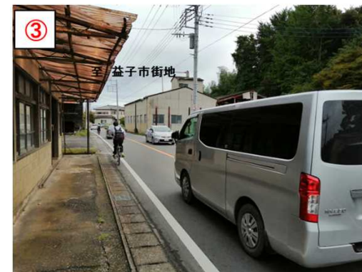
■人家が連坦し拡幅が困難な状況
