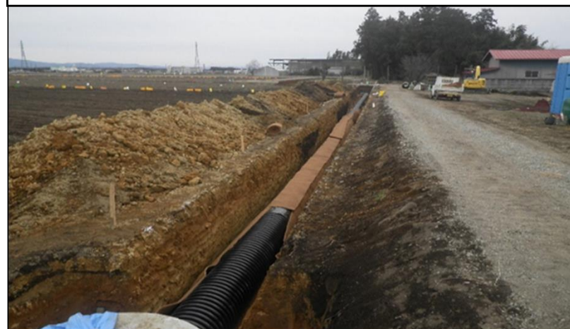
排水暗渠の施工の様子
