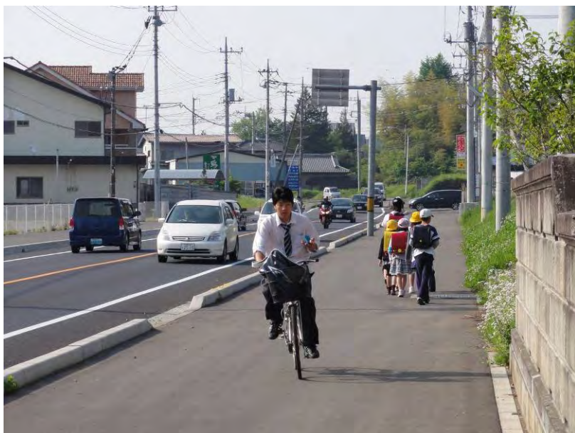
写真3：部分供用状況（現道拡幅部、片岡地内）
