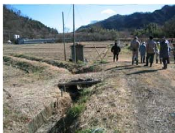
農業用排水施設（整備前）
