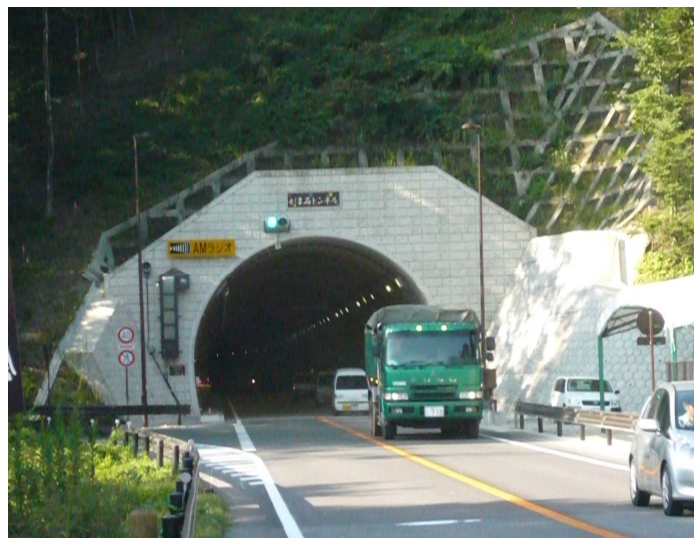
写真 3 : 供用済区間 (がま石トンネル)
