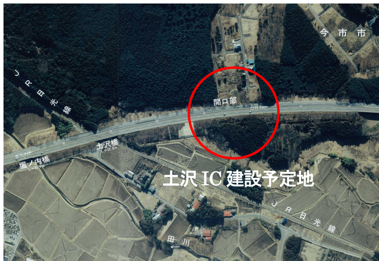
写真2:土沢 IC 状況(整備前)
