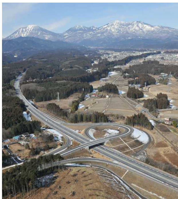
写真3:土沢 IC 状況 (整備後)
