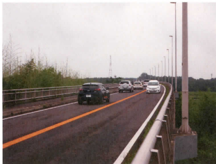
写真 2 : 供用区間 板戸大橋
