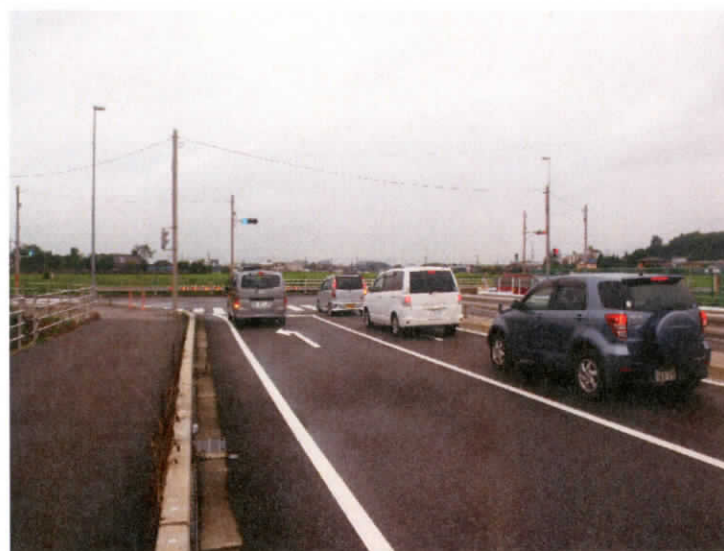
写真 3 : 供用区間 市道 312 号線交差部
