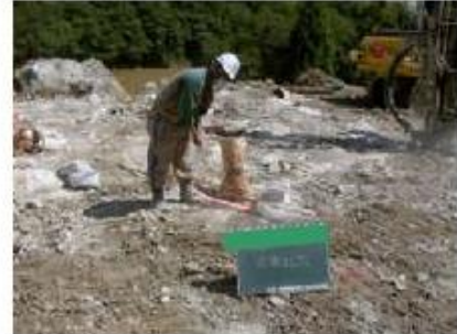
火薬充填状況
