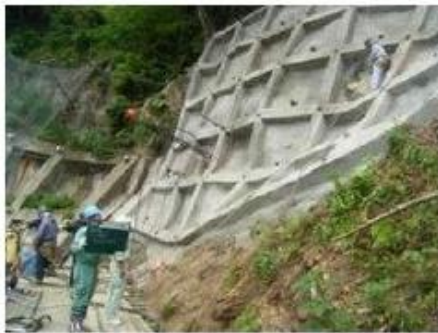
試験施工 削孔状況確認
