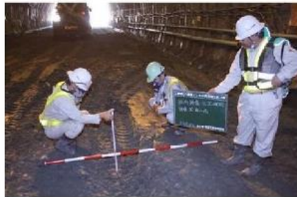
湧水による路盤泥濘化状況
