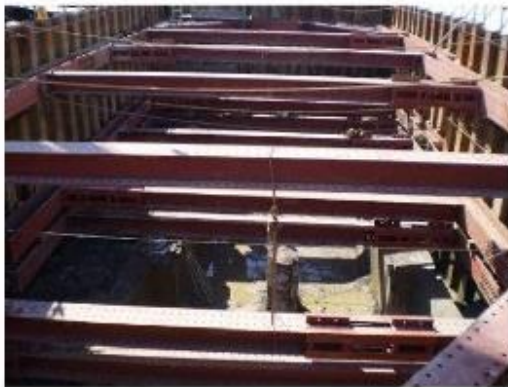
鋼矢板締切全景
