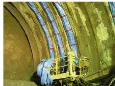
湧水処理施工状況
