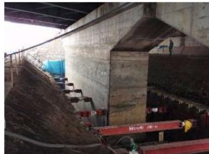
変更後の鋼矢板土留工
