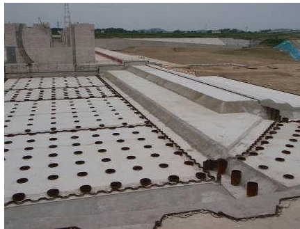
施工ヤード状況
