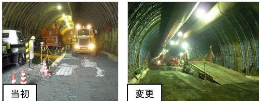
片側施工による大型機械走行状況
