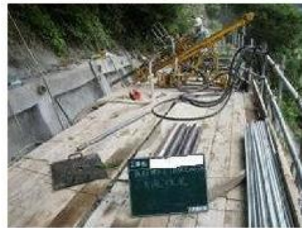
ケーシング併用による削孔
