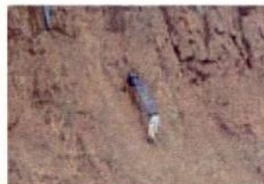
掘削後の切断状況
