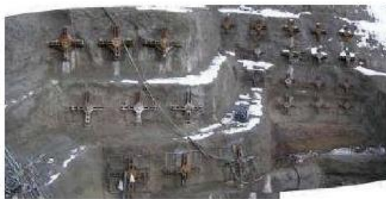
グラウンドアンカー施工状況
