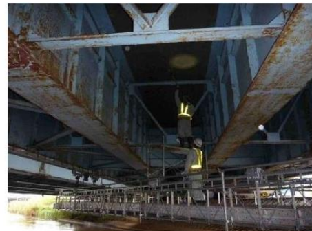
移動式足場による点検
