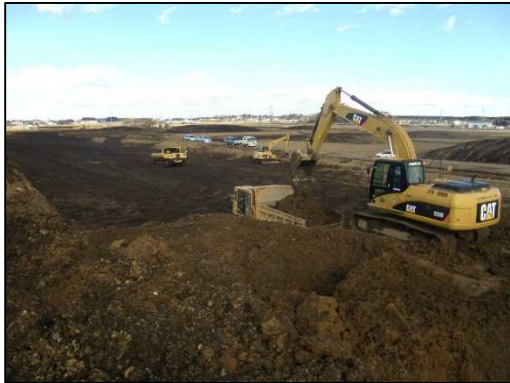
残土運搬状況
