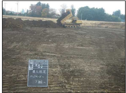
残土運搬状況
