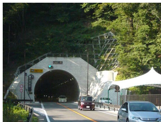
(那須塩原市 一般国道400号がま石トンネル)
