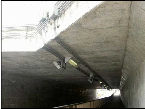
ナトリウムランプ (那須塩原市 (主) 大田原高林線) LEDランプ
