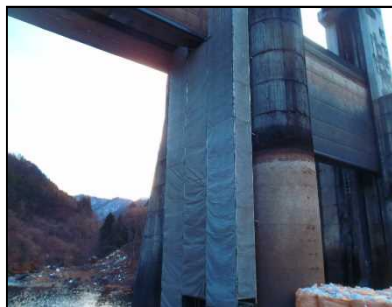
仮設足場設置状況
