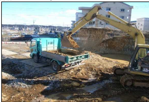
残土搬出状況 (他公共工事)
