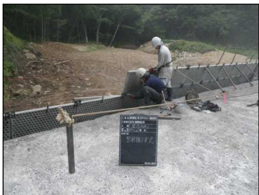
残存型枠施工状況
