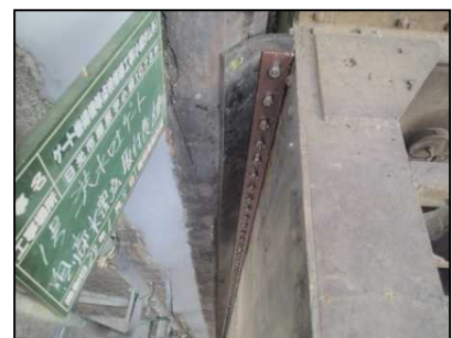
ゲート巻揚機等修繕 (ゲートパッキン交換)
