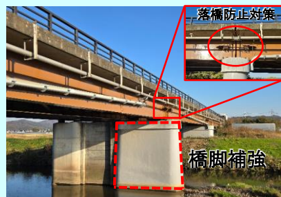
橋梁耐震化 (県道西小埜真岡線/田野橋)
