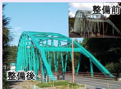
橋梁の長寿命化 (県道黒磯棚倉線/那須塩原市昭明橋)
