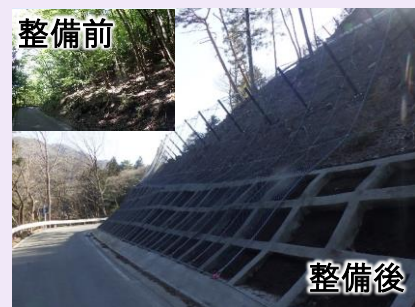
道路法面の防災対策 (県道塩原矢板線/那須塩原市)
