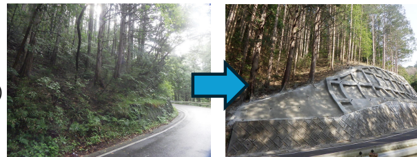
土砂災害対策 (一)松田大月線 松田町／足利市
