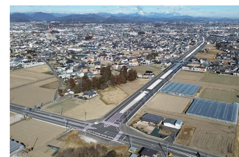
一般広域道路（栃木西部都市連絡道路）の整備 （都）3・3・3号小山栃木都賀線 大宮町工区／栃木市
