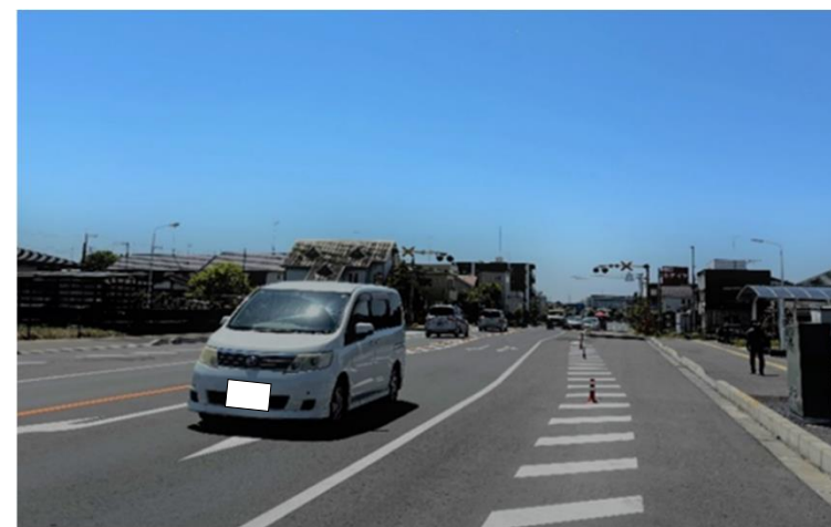
市街地における緊急輸送道路の無電柱化 (一)石末真岡線 真岡市 中郷・萩田
