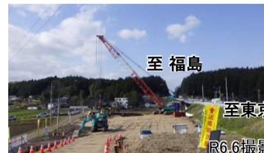
(国)4号 矢板拡幅(整備中)／矢板市
