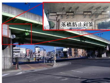
橋梁耐震化 （主）宇都宮向田線／宇都宮市
