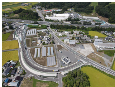
都賀西方スマートIC／栃木市
