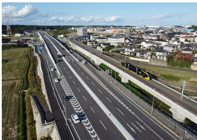
高規格道路の4車線化 (国)408号 宇都宮高根沢バイパス(野高谷立体)
