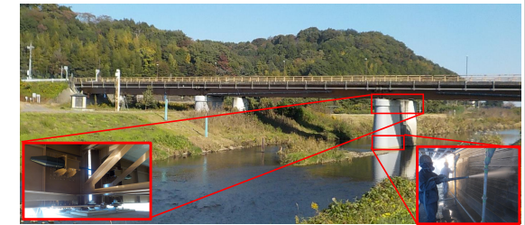
橋梁耐震化・老朽化対策 (一)西小埜真岡線 田野橋／益子町
