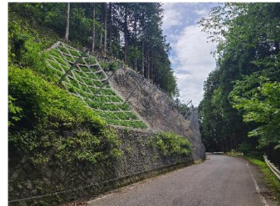
法面崩壊対策 （主）鹿沼日光線／鹿沼市
