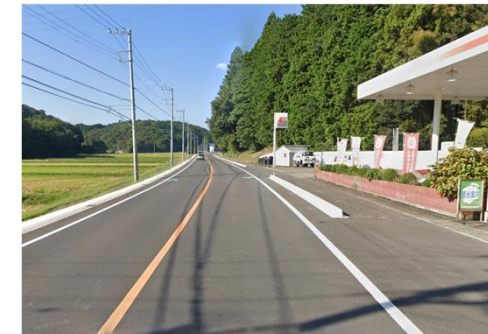
(国)293号 三輪工区／那珂川町
