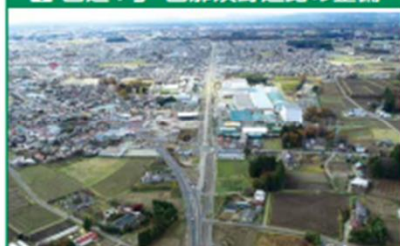
那須塩原市鳥ヶ森公園付近の施工状況
