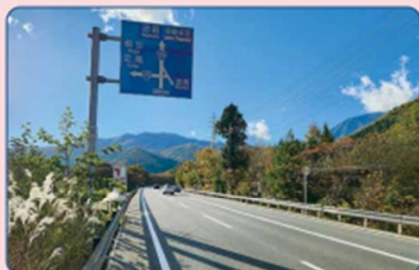
国道120号/日光市
