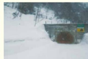
冬期閉鎖前の金精トンネル
