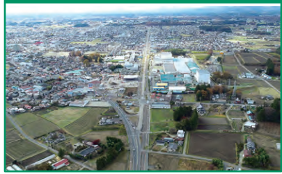
那須塩原市烏ヶ森公園付近の施工状況
