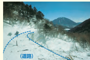
金精峠の雪崩状況
