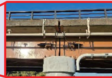
落橋防止対策
