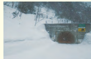
冬期閉鎖前の金精トンネル
