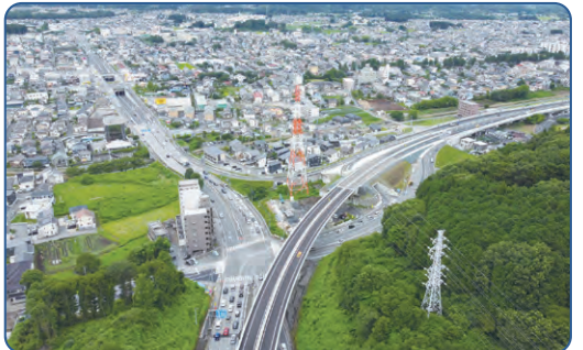
宇都宮環状北道路 上戸祭立体供用状況 2022.7
