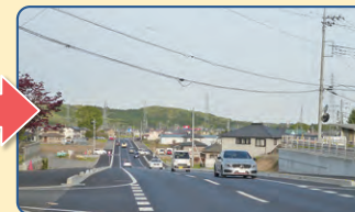
対策後(バイパス整備)
