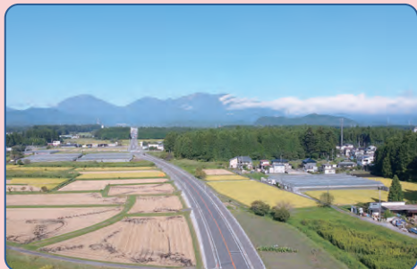
国道119号/日光市
