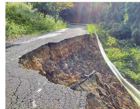
県道県民の森矢板線 矢板市長井
