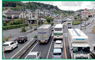
渋滞している未整備区間の国道4号(矢板市 中付近)
