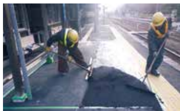
ホームの修繕(わたらせ渓谷鐵道)
