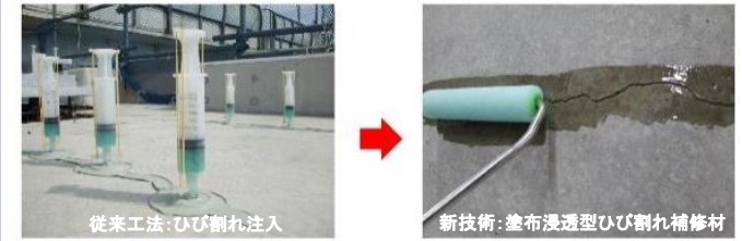
• 新工法を用いたひび割れ補修参考例
