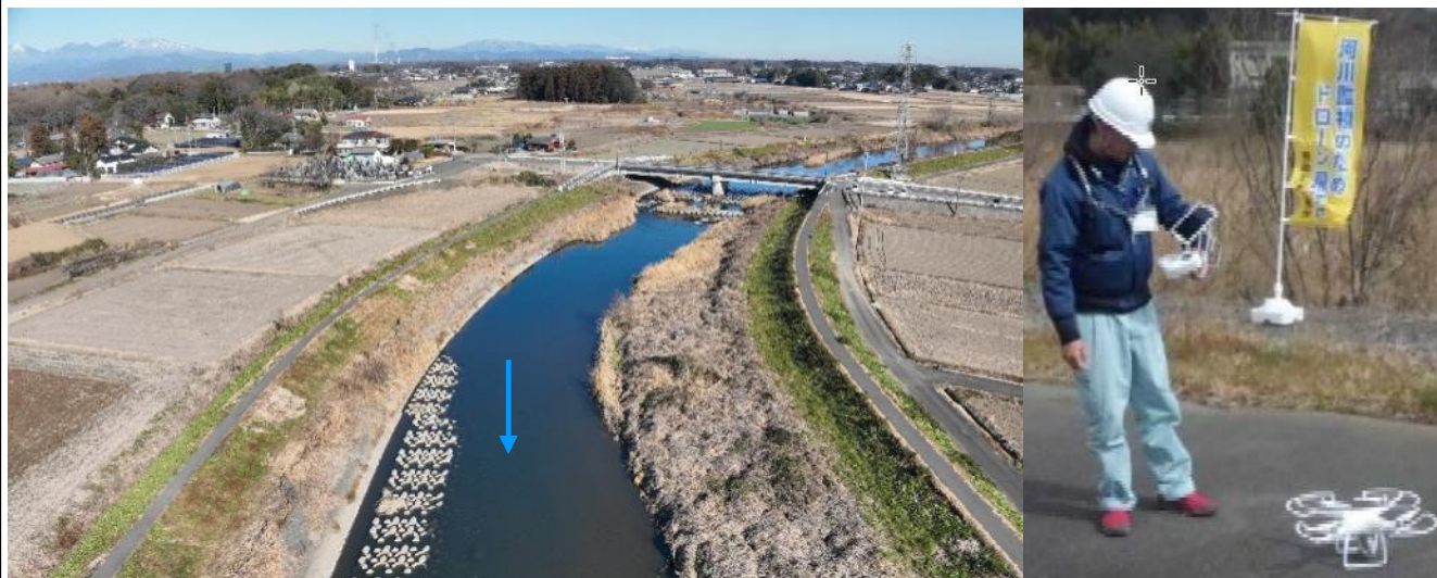
UAVを活用した目視点検
